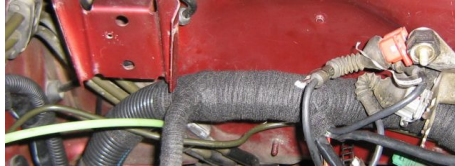
Kabelbaum mit Schutzschlauch
